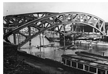
Берлинский мост Янновица после разрушения
